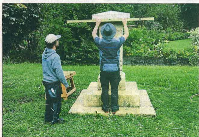
Steinmetzmeister Hannes Braun misst noch einmal, ob das Kapitell „in der Waage“ ist.
