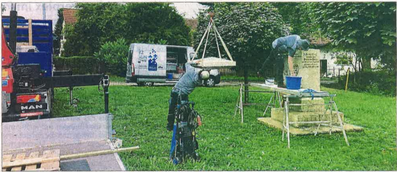
Mit Hilfe eines Krans wurde das Kapitell auf den Gedenkstein gesetzt – es wiegt etwa 360 Kilogramm.
