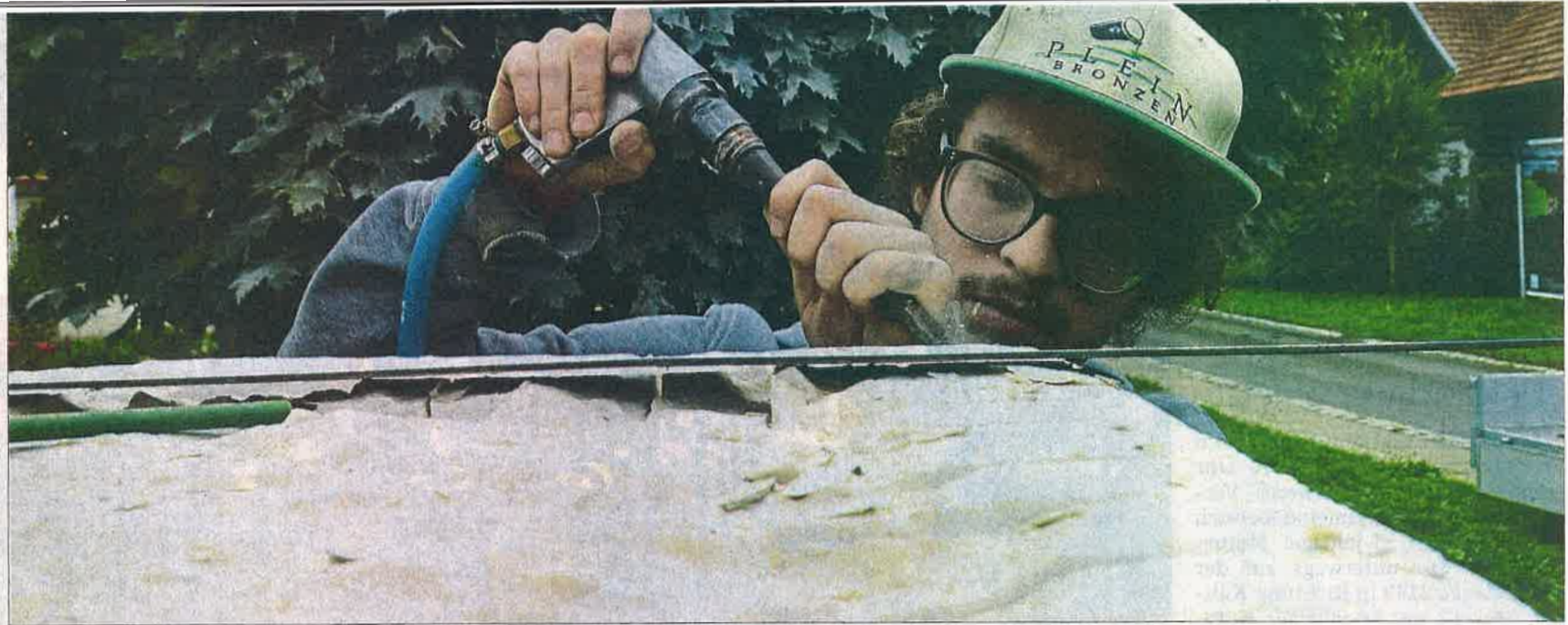
Die ursprünglich spitz zulaufende Ausführung wurde abgetragen, um das neue Kapitell aufsetzen zu können.
